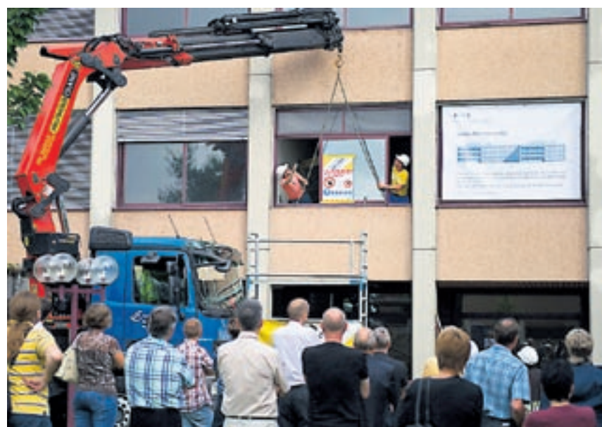
Spatenstich in Eembrach: Aus den früheren Psychiatrie- werden Pflegeräume. Bild: uja
